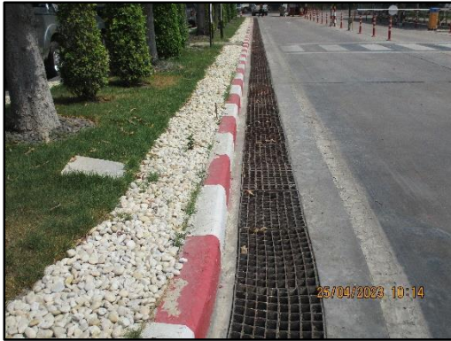
ภาพที่ 2.18 ตะแกรงและฝาปิดครอบรางระบายน้ำ
