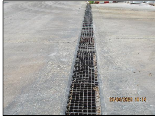
ภาพที่ 2.18 ตะแกรงและฝาปิดครอบรางระบายน้ำ
