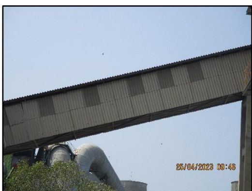
ภาพที่ 2.13 ระบบสายพานลำเลียงวัตถุดิบและเชื้อเพลิงเป็นระบบปิด
